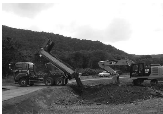
写真-3 河川残土の搬入状況
