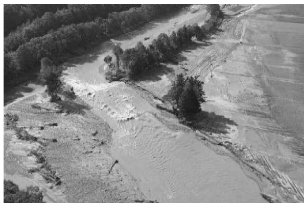
写真-1 空知川の堤防決壊状況
