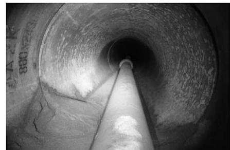
写真-9 管口カメラで撮影したさや管
