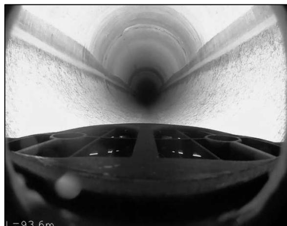
写真-5 FPV操縦タブレットに映し出された管渠内映像（操縦画面であり、録画保存する画像とは別）
