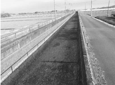
写真 1 表面被覆工法施工前
