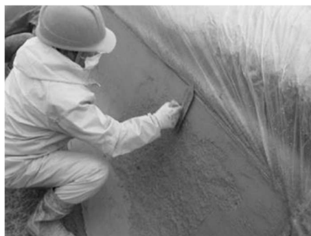
写真 4 従来の粗仕上げ状況
