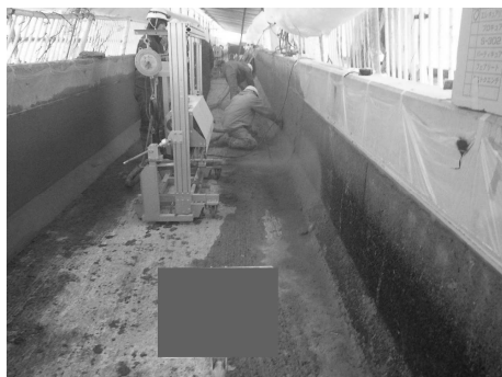
写真 10 吹き付け機施工状況
