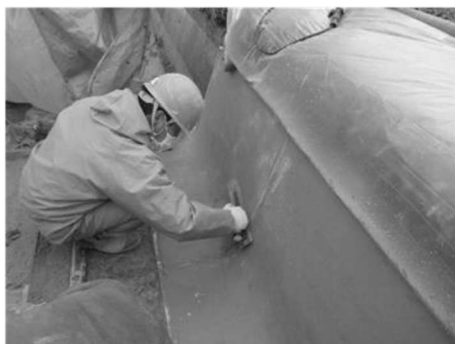
写真 5 表面仕上げ状況
