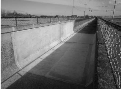
写真 2 表面被覆工法施工後
