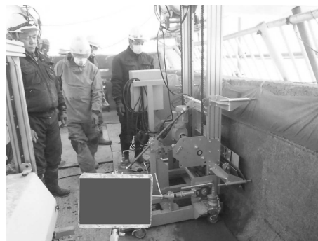
写真 11 均し機施工状況
