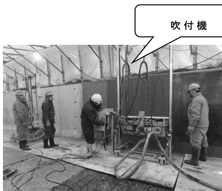
写真 6 モルタル吹付状況
