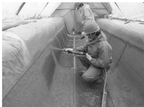
写真 3 従来のモルタル吹付け状況
