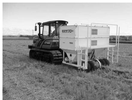
写真-8 補助暗渠施工状況
