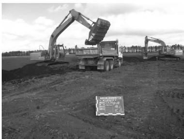
写真-9 採礫および運搬
