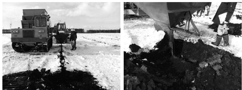
写真-2 補助暗渠（有材心土破碎）の施工状況
