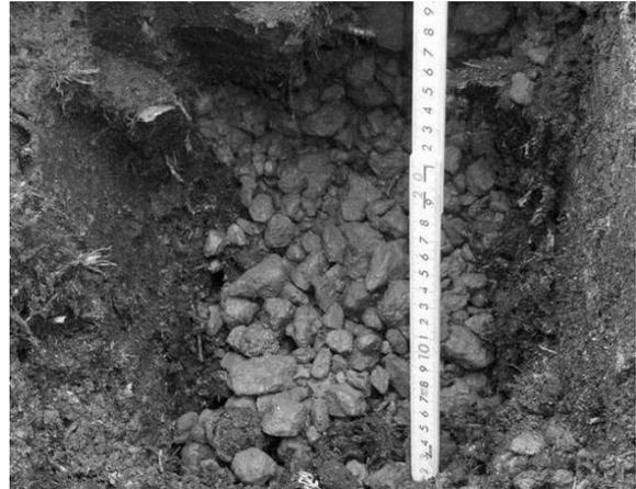
写真 3-2-1 疎水材（再生骨材）の確認状況
