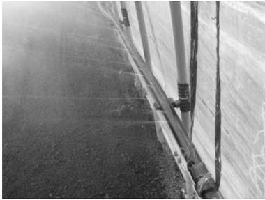
写真-7 多孔管 (片側散水)
