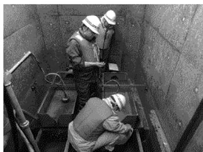
写真－６ 漏水量確認
