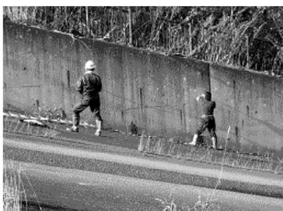
写真-11 洪水吐側壁補修
