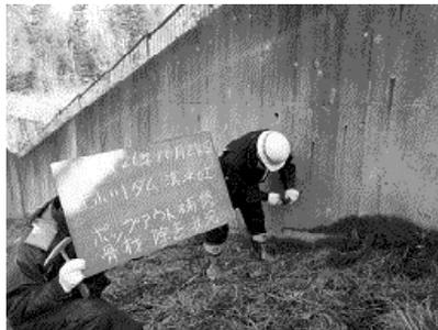
写真-12 洪水吐側壁補修
