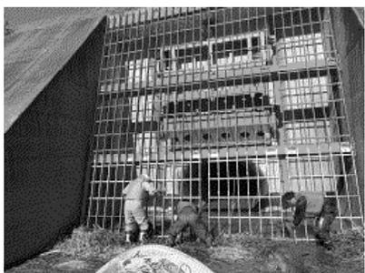
写真-14 調節工流木撤去
