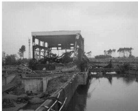
写真-2 津波による排水機場の被災
