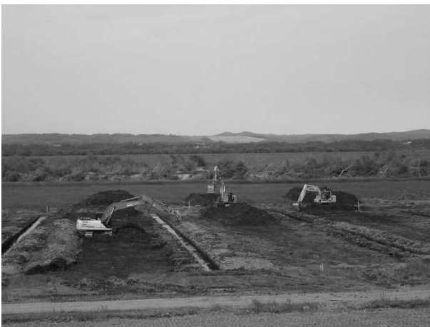
写真-8 河川掘削土掘削状況
