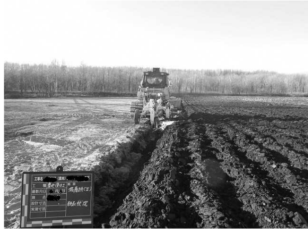
写真-11 砂のすき込み工事状況
