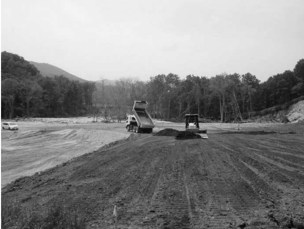
写真-10 河川掘削土敷き均し
