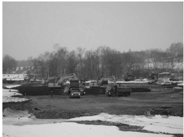
写真-9 河川掘削土搬入状況
