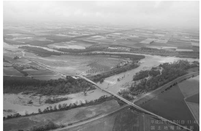
写真-1 十勝管内札内川戸蔦別川合流点被災箇所
