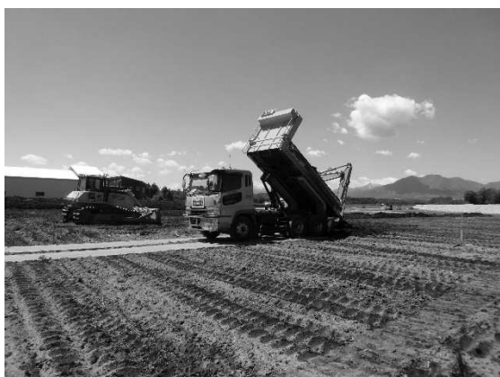
写真-2 河川掘削土の搬入状況
