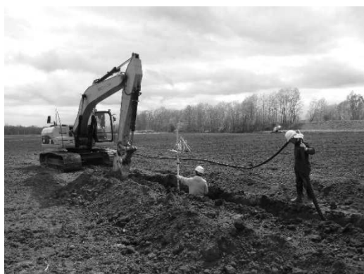
写真-9 暗渠排水工事の状況
