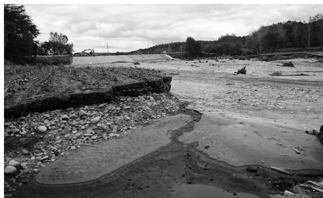
写真-1 被害状況（芽室町）
