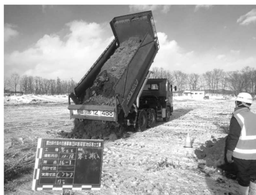
写真-10 客土工事の状況
