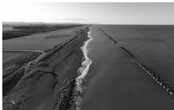
写真-2 湧別町東海岸 離岸堤空撮
