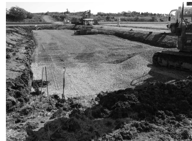
写真-1 全面疎水材設置
