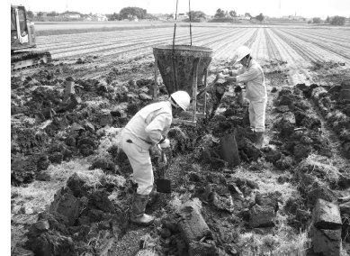
写真-2 溝型疎水材設置
