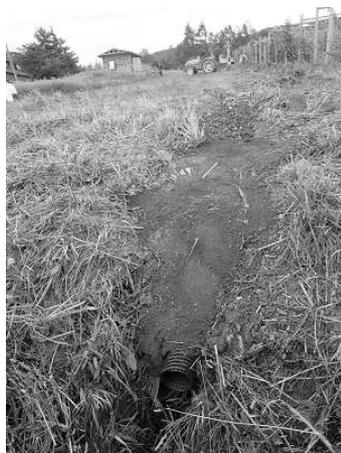
写真1 傾斜下部通路沿いに施工した疎水材暗渠
