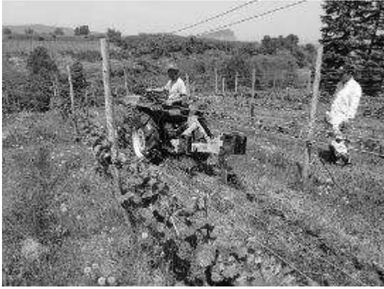
写真 2 滞水部への穿孔暗渠の施工
