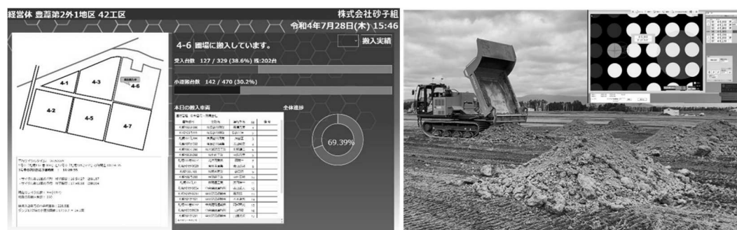
図10：客土材にかかる搬入量管理システム（左）と小運搬にかかるデータ管理（右）
