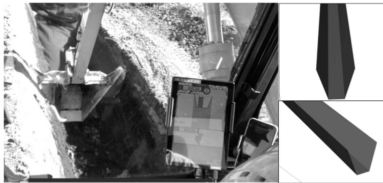
図9：3次元設計データを用いた掘削作業
