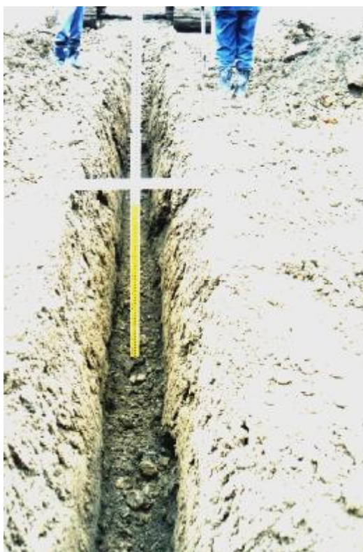
図 19－4 集水渠断面状況写真
