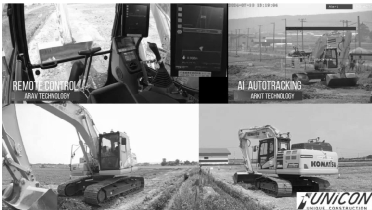
【写真3】試験施工の状況（動画から）
