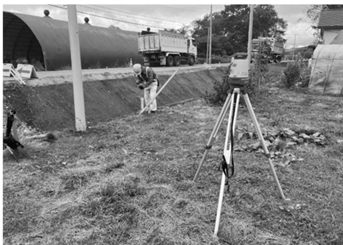
写真-3 杭ナビ利用作業
